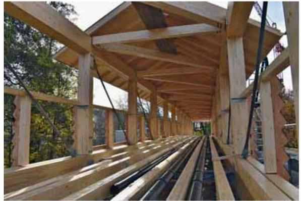
fung der Gesamtkonstruktion. Die an den beiden Brückenecken angeordneten Portalrahmen aus Stahl leiten die Horizontalkräfte, etwa durch Wind auf die Brückenlängsseite, in die Widerlager ab. Die Brücke kommt an einem der beiden Ufer schräg an und endet hier entsprechend mit einem längeren und einem kürzeren Fachwerkbinder, woraus sich ein unsymmetrisches Endfeld ergibt - und dadurch zusätzliche Beanspruchungen entstehen.
