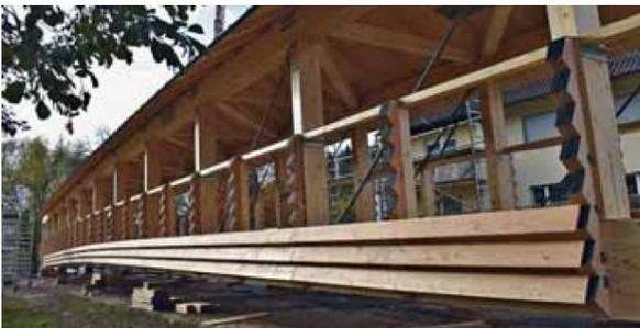
Die Montage der Brüstungsvershaltung erfolgte vor Ort am Ufer. In der Schrägansicht ist auch die Überhöhung der Brücke gut erkennbar. (Foto: Weiß Ingenieure)
