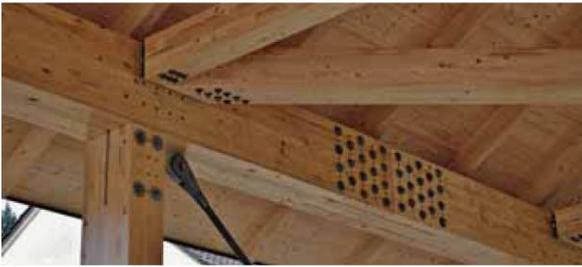
Fachwerkträger mit ungeteiltem Obergurt mit Schlitzblechen für Pfosten und Montagestöße (Foto links). Der Untergurt hingegen ist zweiteilig konstruiert (Foto rechts), damit er die Anschlussbleche aufnehmen kann. Zwischen die Längsträger wurden Leerrohre für Infrastruktur eingelegt. (Fotos: Weiß Ingenieure)
