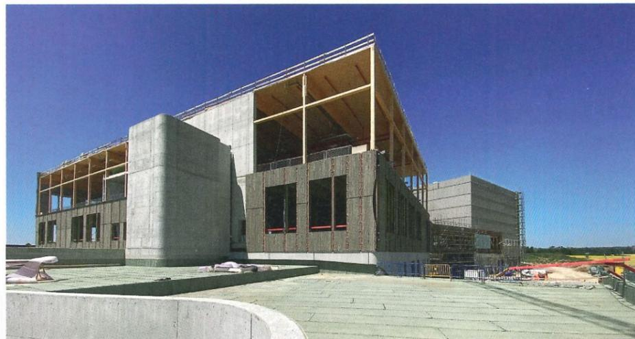
▲ Das viergeschossige Funktionsgebäude kombiniert eine Betonkonstruktion im Unter-, Erd- und 1. Obergeschoss mit einer vorgehängten Holzfassade und einem 2. Obergeschoss in Holzskelettbauweise mit Satteldachbindern
