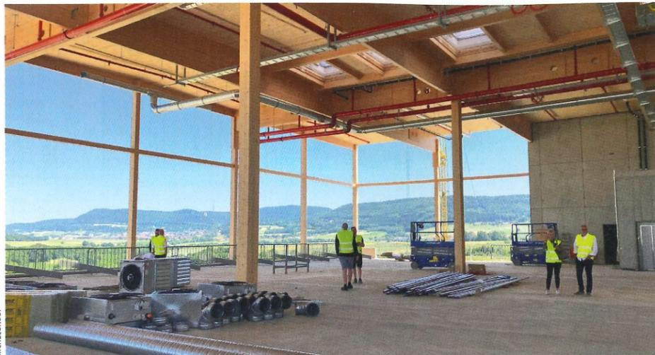
▲ Die Tragkonstruktion des Funktionsgebäudes ist bereits montiert. Es fehlen nur noch die Fassaden
