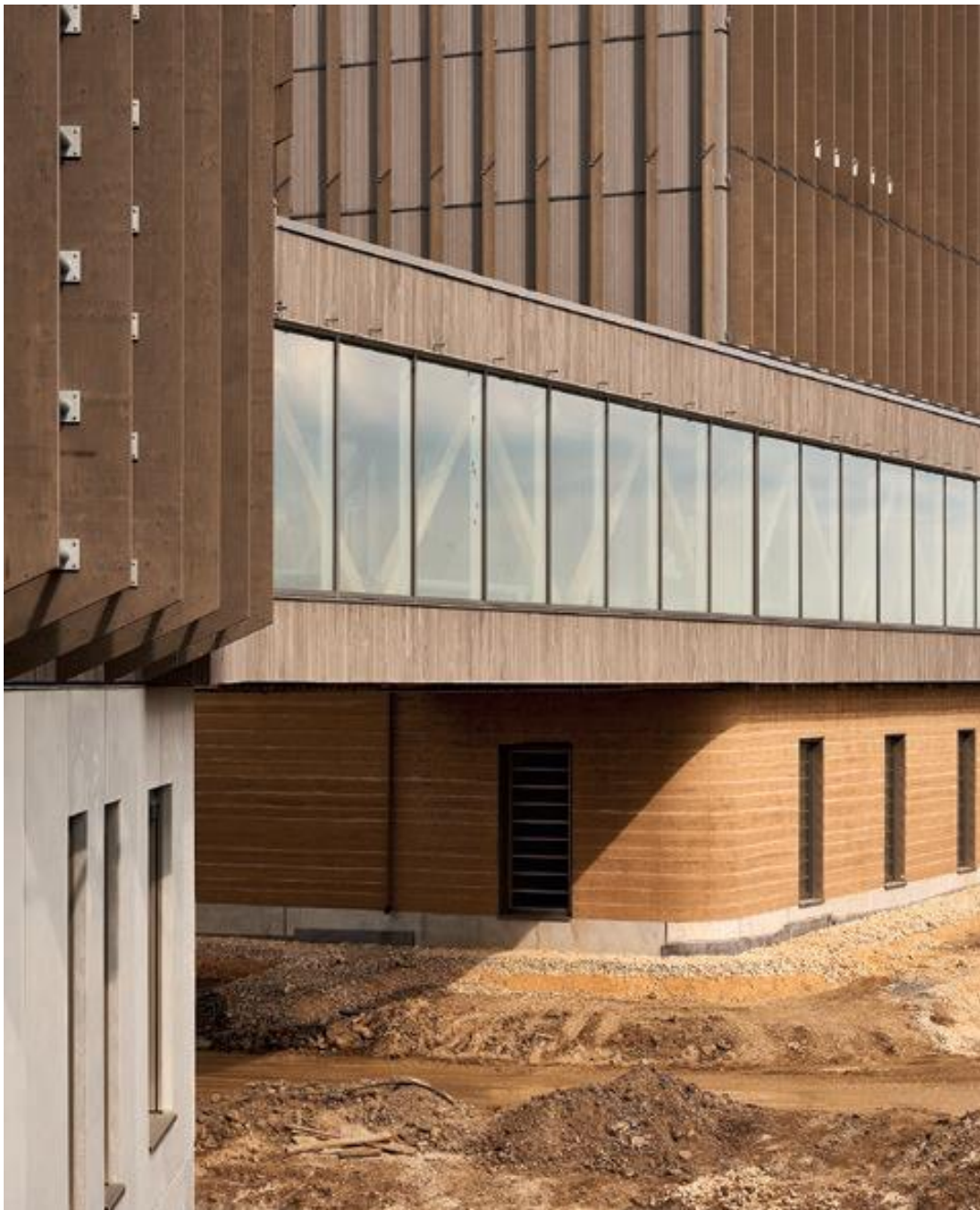
Abbildung 13: Lehmwand HRL [Elias Hassos]
