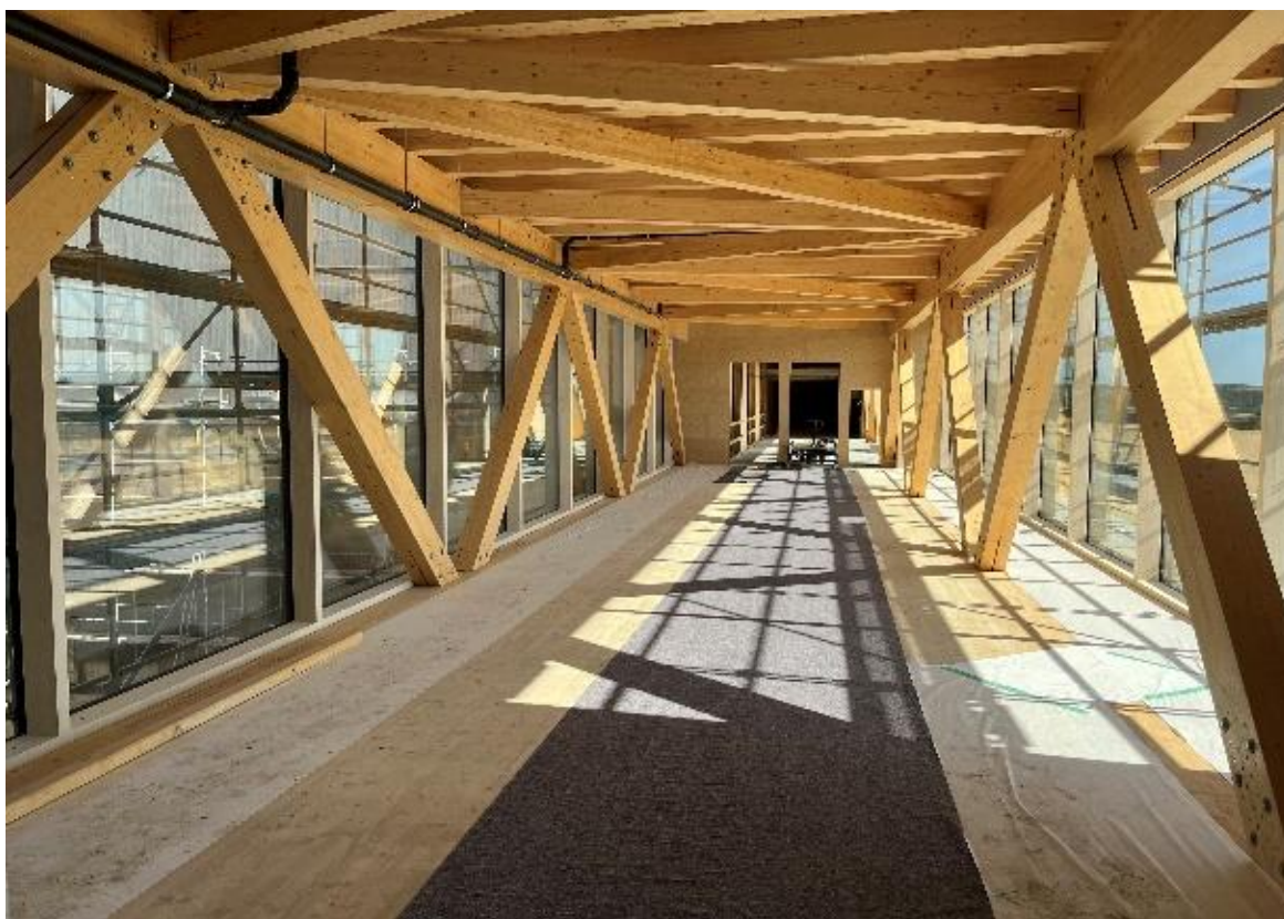
Abbildung 17: Verbindungbrücke [Holzbau Amann]
