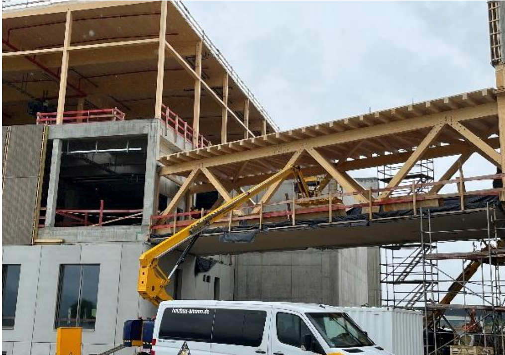
Abbildung 22: Verbindungsbrücke [Holzbau Amann]
