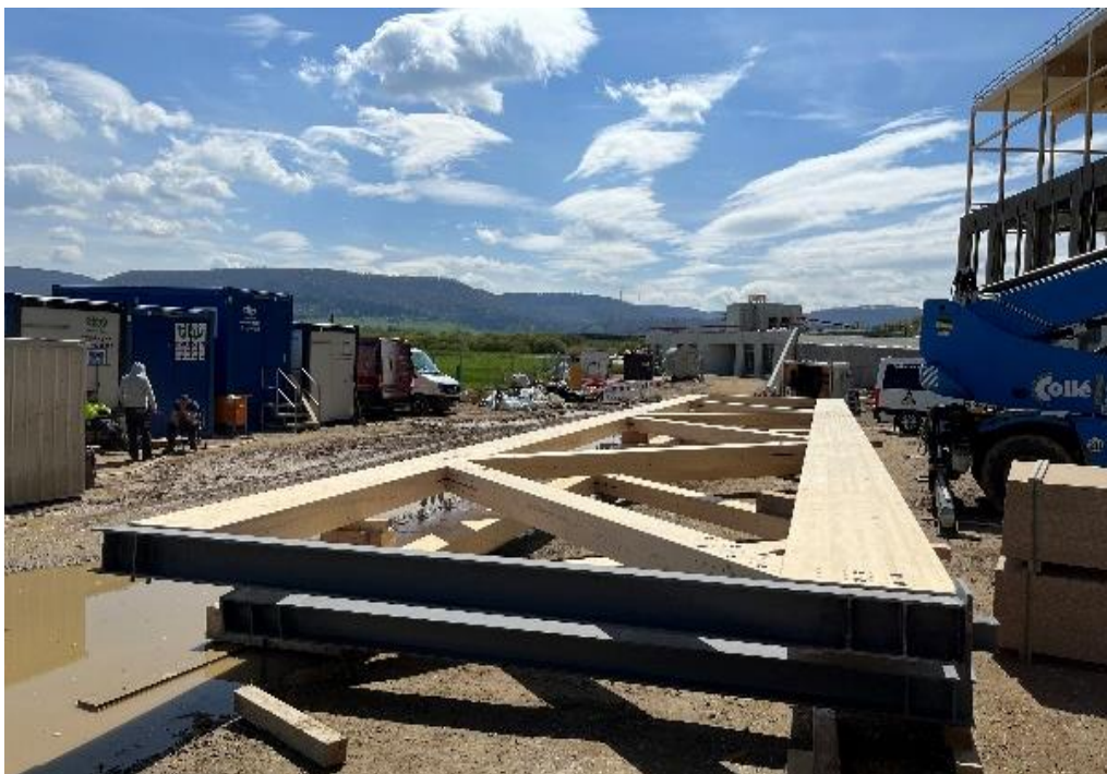
Abbildung 23: Fachwerkbinder [Holzbau Amann]
