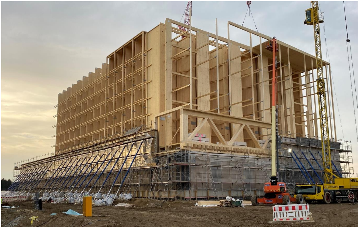
Abbildung 9: Bauphase Holzregal [Michelgroup]
