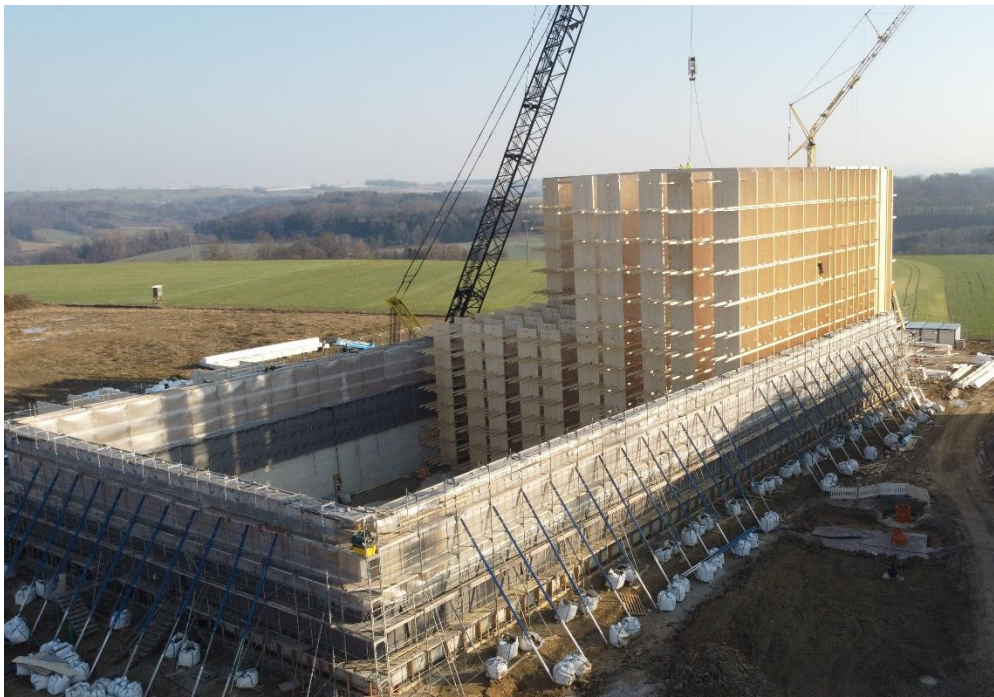
Abbildung 8: Bauphase Holzregal [Kaufmann Bausysteme]
