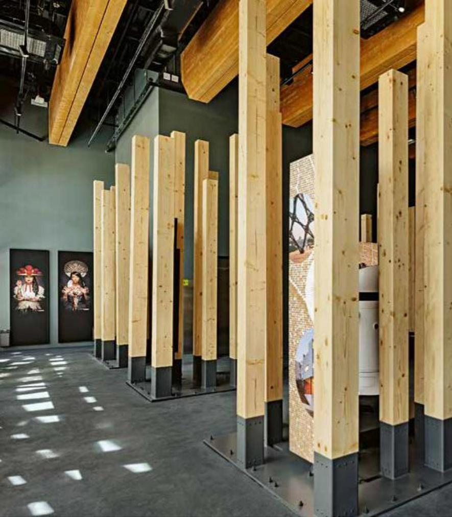
▲ Die Dachkonstruktion basiert auf doppelten BSH-Trägern, die per Vollmomentenstoß bzw. BSB-Verbindungen mit der Wandkonstruktion gekoppelt wurden
