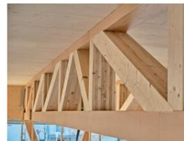
↑↑ Blick in die Dachkonstruktion aus Fachwerkträgern, von denen später nur noch die Untergurte zu sehen sind.
