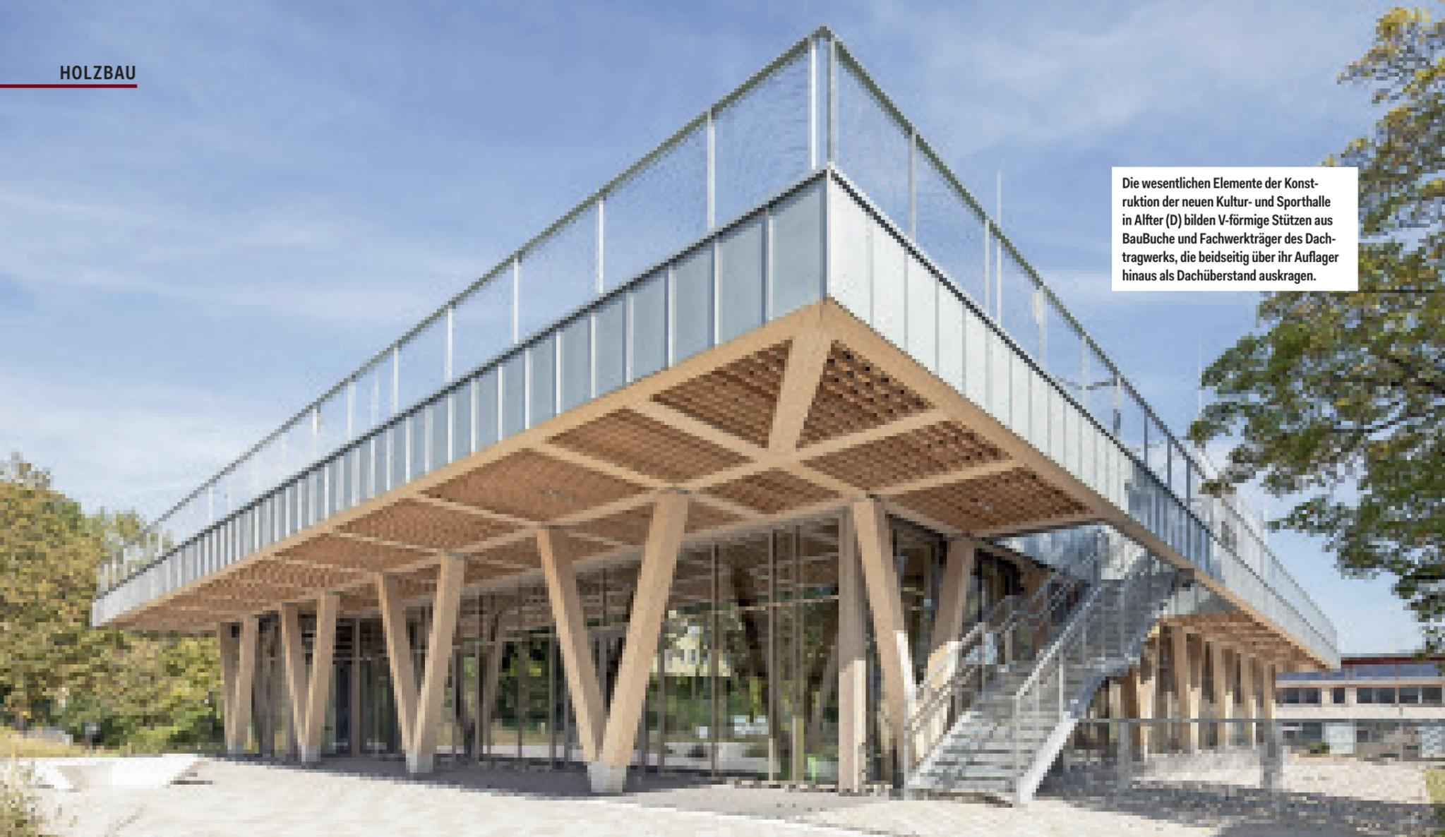
Die wesentlichen Elemente der Konstruktion der neuen Kultur- und Sporthalle in Alfter (D) bilden V-förmige Stützen aus BauBuche und Fachwerkträger des Dachtragwerks, die beidseitig über ihr Auflager hinaus als Dachüberstand auskragen.
