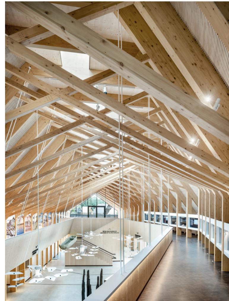
Die Galerie wurde mittels Zugstangen vom Dach abgehängt. Holz dominiert den gesamten Innenraum.
