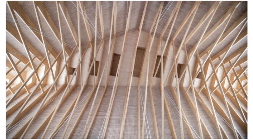
Die unterspannten Brettschichtholz-Träger wurden im Abstand von 1,6m angeordnet. Die tragende Rahmenkonstruktion geht in vertikale Stützen über, zur Aussteifung dient eine scheibenartige Zwischendecke.
