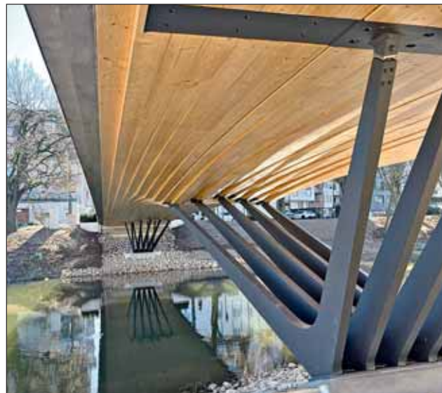
Die 55 m lange Rathausbrücke in Tuttlingen ist eine Holz-Beton-Verbund-Konstruktion mit 6 m Breite. Das Rahmentragwerk wird von V-förmigen, in sich aufgelösten Stahlstützen getragen. Foto: Schlaich Bergermann Partner
