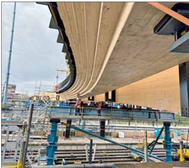
Über zwölf Gleise führt die 130 m lange Fußgänger- und Radfahrer-Brücke in Zwolle. Der Brückenquerschnitt besteht aus vier blockverklebten Brettschichtholz-Trägern, die über Stahlträger gekoppelt sind. Foto: Schmees und Lühn
