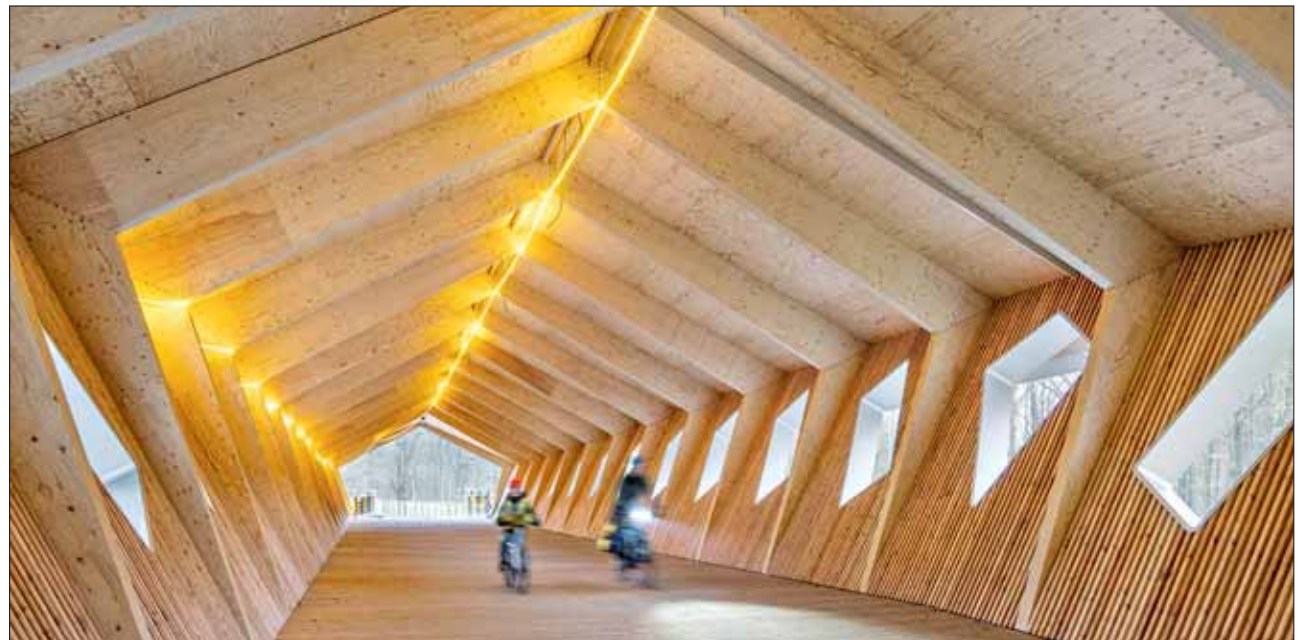
Innenansicht der 67,50 m langen Brücke über den Brüsseler Ring in Tervuren/Belgien, die als polygonale Röhre aus GLVL-Platten ausgebildet und alle 3 m durch Querrippen verstärkt wurde. Die Brücken-„Box“ hält als geschützte Konstruktion sowohl die Konstruktion aus auch die Benutzer trocken. Foto: Corentin Haubridge
