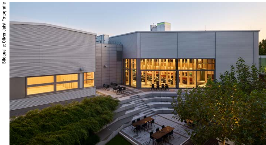
Der mittels Pfosten-Riegel-Konstruktion weitgehend verglaste Eingangsbereich und der angrenzende Mehrzweckraum (links).
