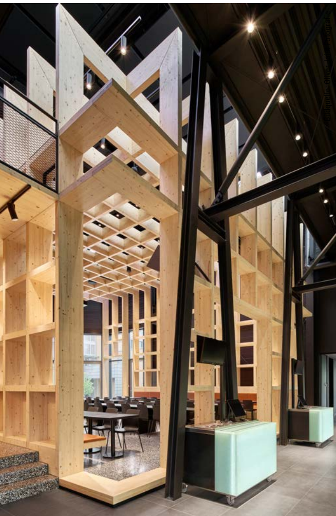
Um das BSH-Skelett auszusteuern hat man dieses an die äußeren Stützen der alten Stahlkonstruktion angebunden.
