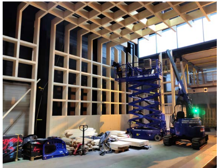
Die Montage des BSH-Tragwerks in beengten Platzverhältnisse erfolgte mit einem elektrischen Kleinkran.
