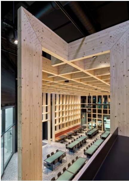
Das Obergeschoß wartet mit umfänglichen Blickfeldern auf, und offenbart auch filigrane Anschlussdetails, wie z.B. die runden Metallpunkte der Stabdübel in den Rahmenecken.
