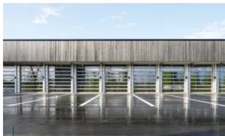
Frontalansicht der Fahrzeughalle
