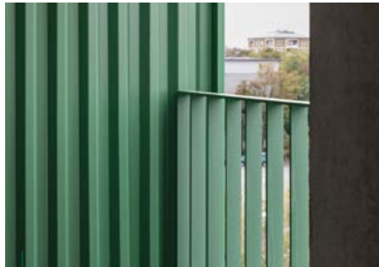
Trapezblechfassade mit Staketengeländer
