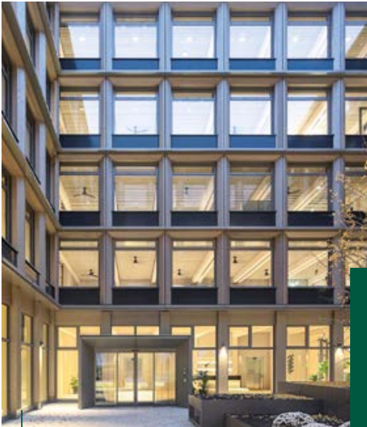
Innenhof, Modulansicht außen
