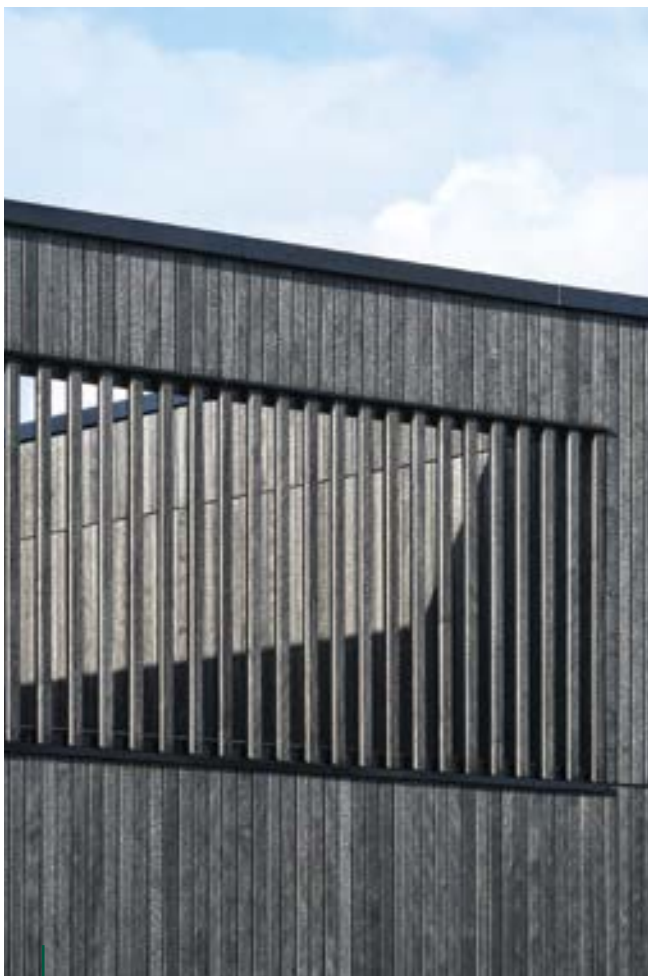
Detail der karbonisierten Holzfassade
