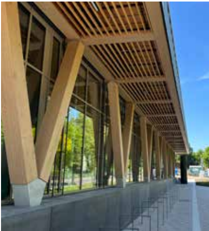
Bild 18: Die großen Dachüberstände sorgen für den Witterungsschutz der Baubuche-V-Stützen und im Sommer für die Verschattung im Erdgeschoss sowie in der Halle. (Foto: PIRMIN JUNG Deutschland)
