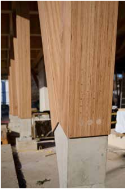
Bild 10: Die Baubuche-Stützen (b x h: 32 cm x 30 cm) sind auf Fertigteil-Klötzen mit einbetonierten Stahlteilen angeschlossen. (Foto: Holzbau Amann)
