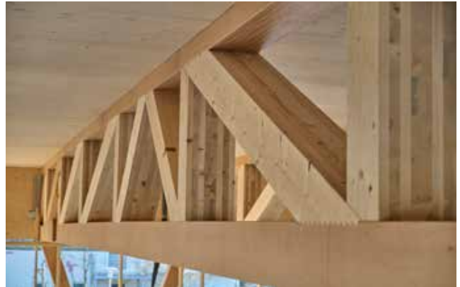
Bild 5: Außergewöhnlich: Die Mischkonstruktion der Fachwerkträger aus Baubuche, Brettspertholz und Brettschichtholz, um die Lasten in den Gurten, Pfosten und Diagonalen holzartenspezifisch aufzunehmen. (Foto: Holzbau Amann)
