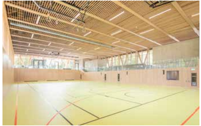
Bild 3b: Der im Erdreich stehende Hallenbereich ist als Stahlbeton-Wanne ausgeführt. Für den Aufzugsschacht sowie die Kerne für die sanitären Einrichtungen – beidseitig der Tribüne zu sehen – kam ebenfalls Stahlbeton zum Einsatz. (Foto: Margot Gottschling)
