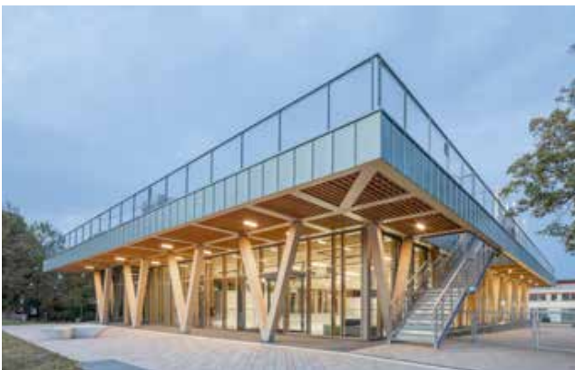
Bild 1: Die wesentlichen Elemente der Konstruktion der neuen Kultur- und Sporthalle in Alfter bilden V-förmige Stützen aus Baubuche und Fachwerkträger des Dachtragwerks, die beidseitig über ihr Auflager hinaus als Dachüberstand auskragen. (Foto: Margot Gottschling)
