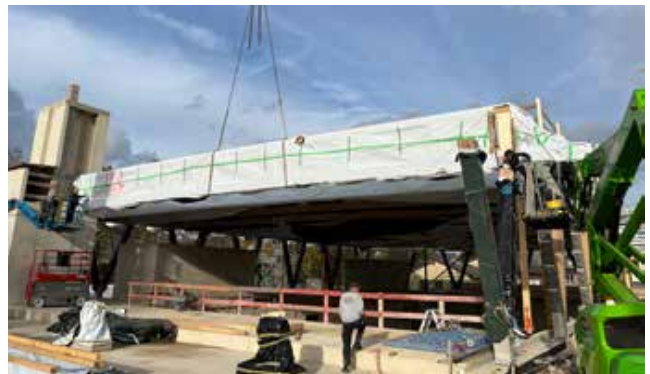
Bild 7: Ein Kran setzte die rundum mit Folien vor Witterung geschützten Fachwerkträger auf den jeweiligen „Armen“ der V-Stützen ab. Sie überspannen 24 m und kragen beidseitig 2 m als Dachüberstand über die Stützen aus. (Foto: Holzbau Amann)
