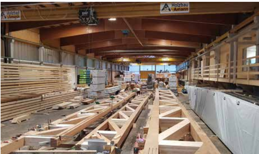
Bild 12: Vorfertigung der 28 m langen Fachwerkträger mit 90 mm Überhöhung im Werk von Holzbau Amann. (Foto: Holzbau Amann)
