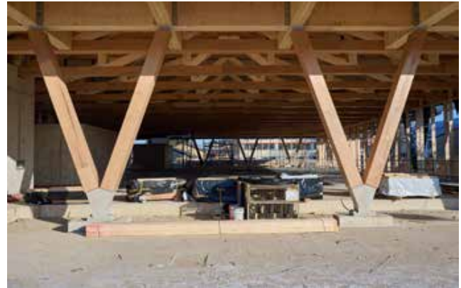
Bild 9: Blick in das Dachtragwerk aus Fachwerkbindern, von denen später nur noch die Untergurte zu sehen sind (siehe Hallen-Innenansicht, Bilder 3a und b) (Foto: Holzbau Amann)
