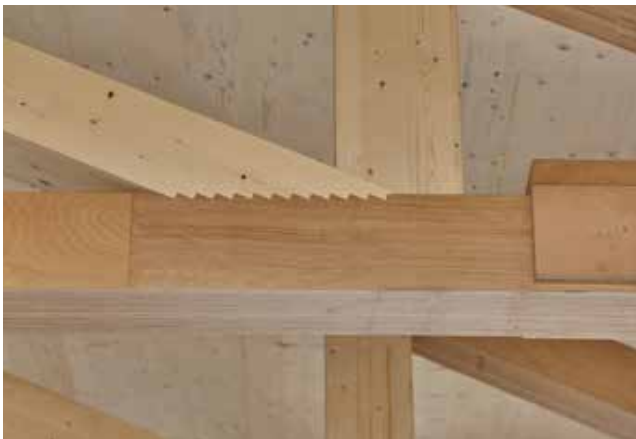
Bild 16: Treppenversätze koppeln die Fachwerk-Diagonalen aus Brett-schicht- und Brettsperrholz mit den Untergurten (und Obergurten). (Foto: Holzbau Amann)
