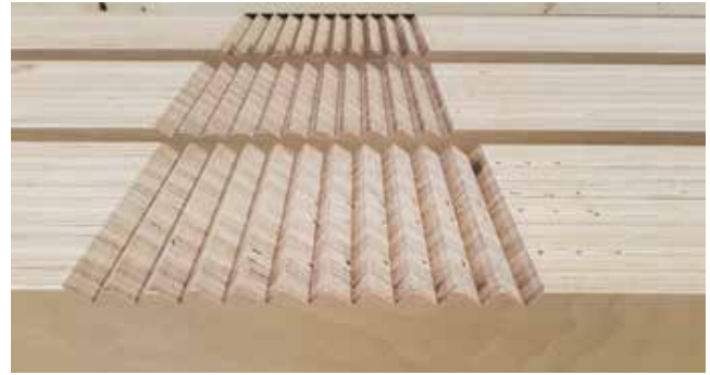
Bild 15: Die exakt gefrästen Treppenversätze in den Gurten sorgen für eine passgenaue Verzahnung mit den Fachwerk-Diagonalen. Durch die größere Kontaktfläche erhöht sich auch die Tragfähigkeit trotz geringer Einschnitttiefe. (Foto: Holzbau Amann)
